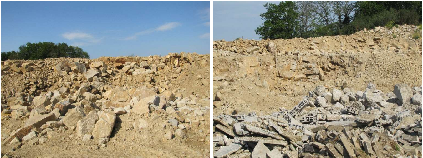
Photos des talus de déchets inertes non stabilisés [photo AXE]
