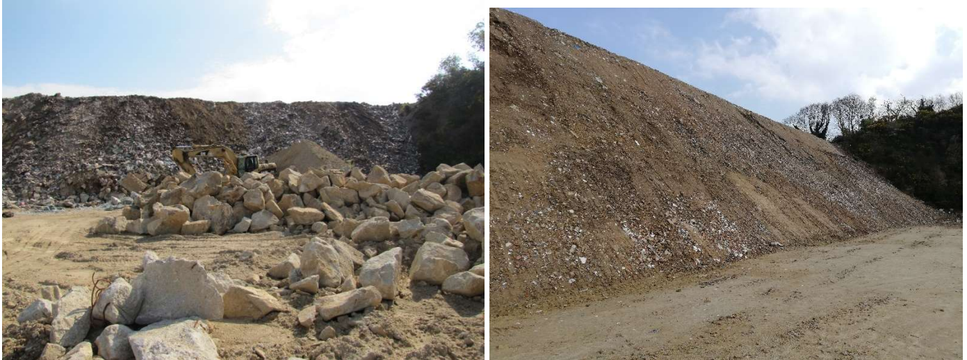
Talus de déchets d'inertes (4) en 2018, puis talus compacté en 2019 [photo AXE]
